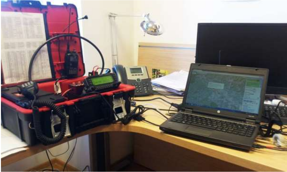
Slika 10: Oprema S50ALJ v pisarni URSJV
